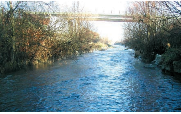
Le Lange avant travaux, en novembre 2006 : lit recalibré, faciès et habitat peu diversifiés.
