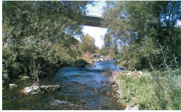
Le Lange un an après la fin des travaux, en 2009 : diversification des habitats et des écoulements.
