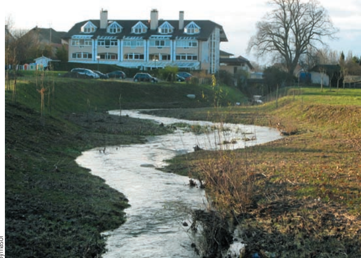
Le secteur 4 de l'Hermance : à gauche, l'Hermance recalibré avant travaux en novembre 2008 ; à droite, le lit moyen élargi de 15 m en rive gauche et 5 m en rive droite, vu en décembre 2009.
