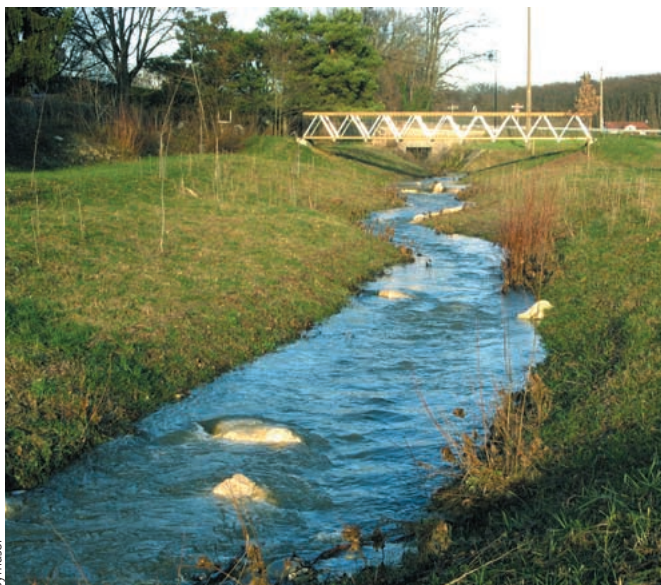
Le secteur 1 de l'Hermance : à gauche, l'Hermance recalibré avant travaux en août 2008 ; à droite, l'élargissement de la section du lit mineur et la plantation en berges, vus en décembre 2009.
