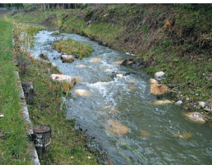
Le secteur 2 de l'Hermance : diversification des écoulements par la pose de blocs et protection des berges en génie végétal (novembre 2009).
