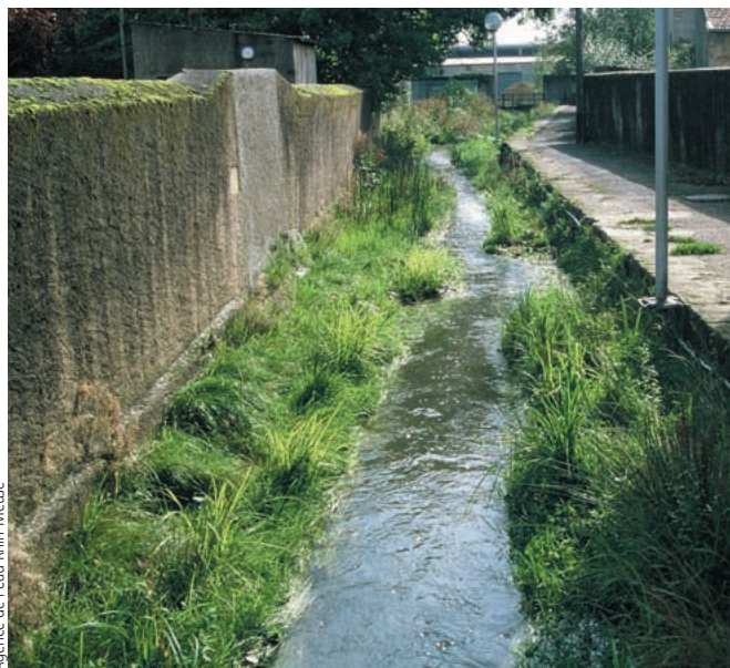
Le ruisseau de Montvaux huit mois après les travaux de restauration. Banquettes végétalisées et plantées, en juin 2000.
