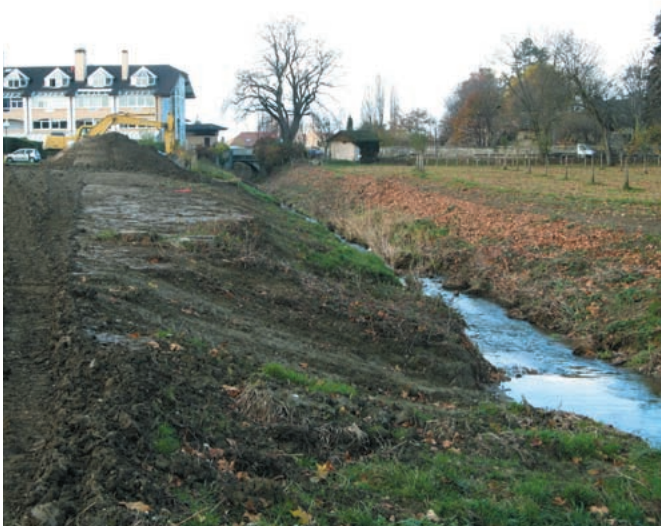
Le secteur 4 de l'Hermance : à gauche, l'Hermance recalibré avant travaux en novembre 2008 ; à droite, le lit moyen élargi de 15 m en rive gauche et 5 m en rive droite, vu en décembre 2009.
