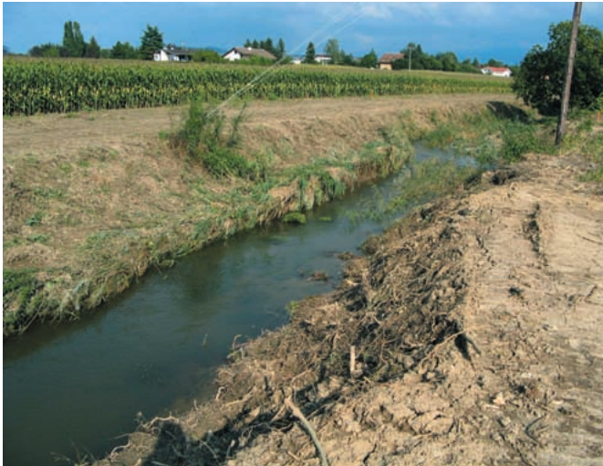
Le secteur 3 de l'Hermance : à gauche, l'Hermance recalibré avant travaux en septembre 2008 ; à droite, l'élargissement du lit du cours d'eau pour lui permettre de reméandrer, vu en décembre 2009.
