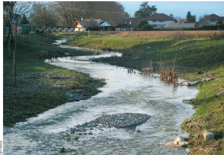
Le secteur 3 de l'Hermance : à gauche, l'Hermance recalibré avant travaux en septembre 2008 ; à droite, l'élargissement du lit du cours d'eau pour lui permettre de reméandrer, vu en décembre 2009.
