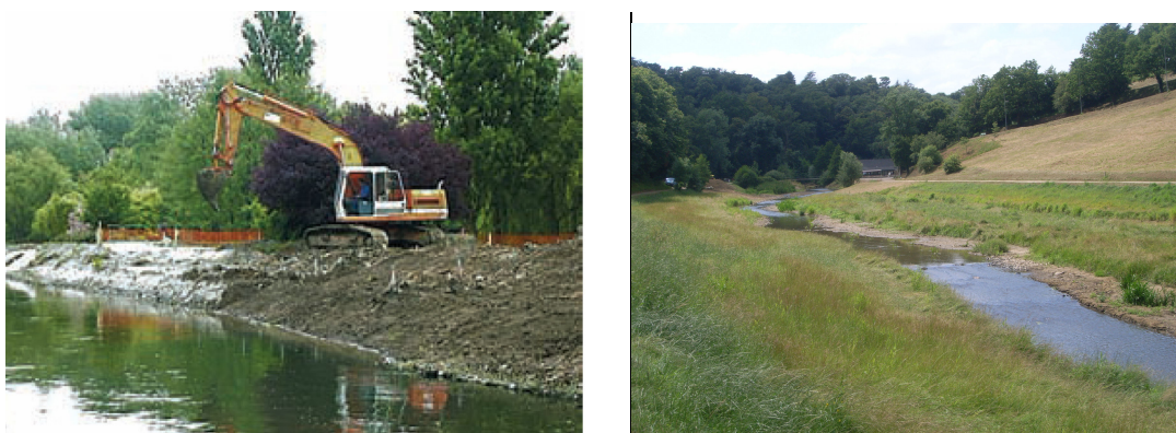
Figure 21 : Exemple de la suppression de protections de berges sur l'Orge (91) et de retour à une dynamique d'écoulement naturel suite à la suppression d'un étang sur le Vicoin (53)
