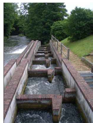
FIGURE 10 : EXEMPLES D’UNE RAMPE EN ENROCHEMENTS ET D’UNE PASSE À BASSINS SUCCESSIFS
