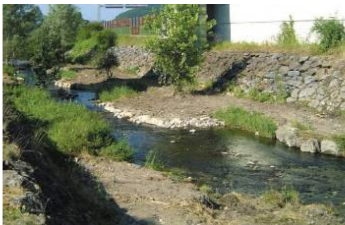
Figure 17 : Exemples d'une opération de restauration de cours d'eau par recréation d'un lit d'étiage et exemple de création de caches par fascinage
