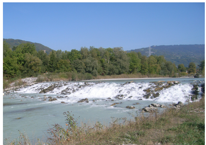
Figure 15 : Exemple de restauration d'un cours d'eau par recharge alluviale et seuil de stabilisation en enrochements sur l'Arve
