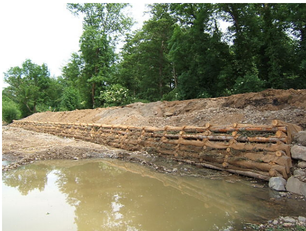
Figure 22 : Exemple de travaux de protection de berge par caissons végétalisés et fascinage (SIGAL)
