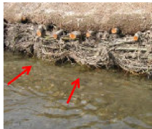
Figure 17 : Exemples d'une opération de restauration de cours d'eau par recréation d'un lit d'étiage et exemple de création de caches par fascinage
