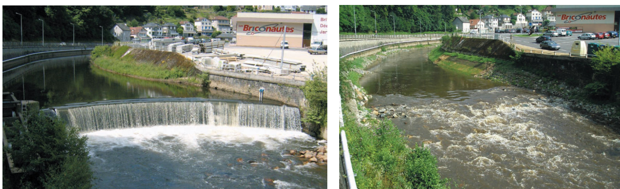
Figure 12 : Exemple de l'abaissement d'un seuil d'un seuil sur la Corrèze
