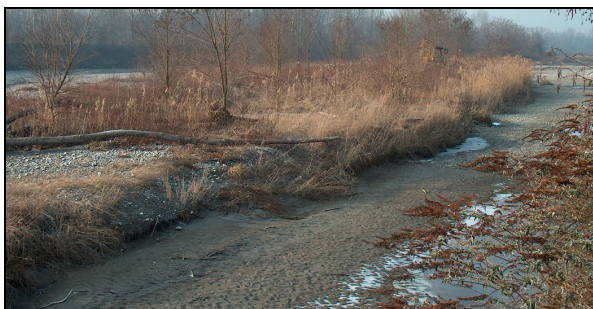
Figure 14 : Exemple du traitement d'un atterrissement sur l'Arve par scarification
