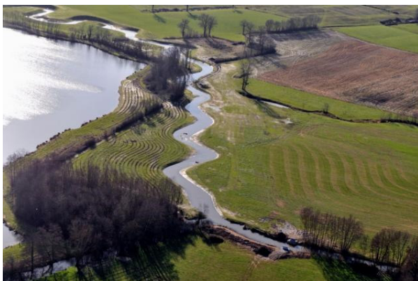
Figure 20 : Exemple de la restauration de la Veyle par dérivation d'une gravière par création d'un nouveau lit (2010, Syndicat de la Veyle Vivante – Vital)
