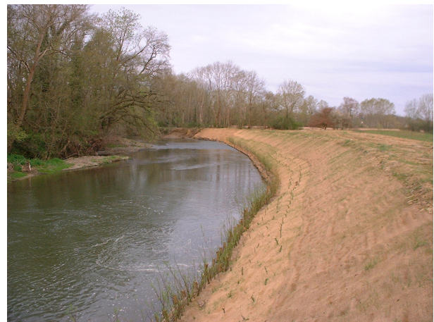
Figure 22 : Exemple de travaux de protection de berge par caissons végétalisés et fascinage (SIGAL)
