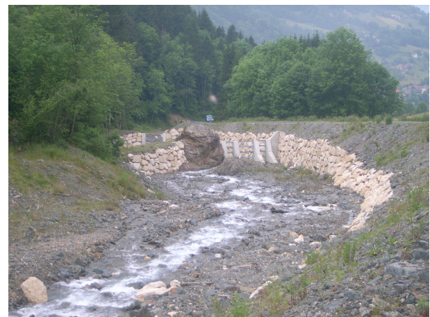
Figure 13 : Exemple de la création d'une zone tampon en aval d'un système de drainage et d'une zone de dépôts de matériaux en milieux montagneux
